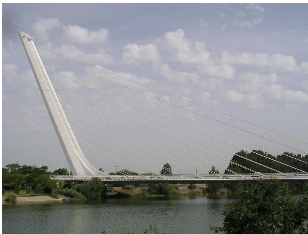
Imagen 20. Puente del Alamillo
